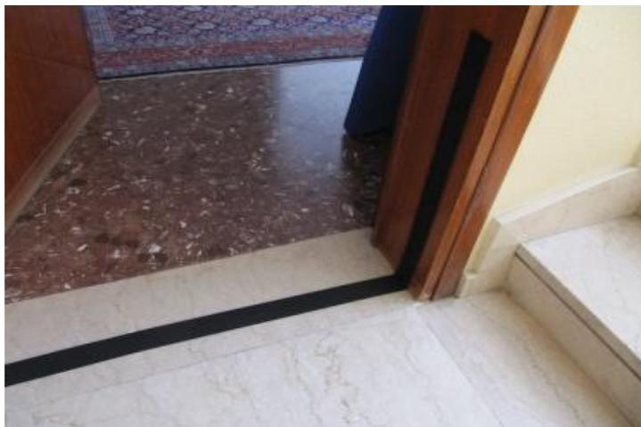
1 ) Posizionare le strisce di neoprene adesivo nero sul pavimento e sulle spallette della porta.
